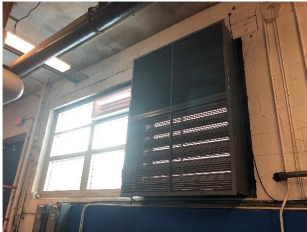
Combustion Louver
