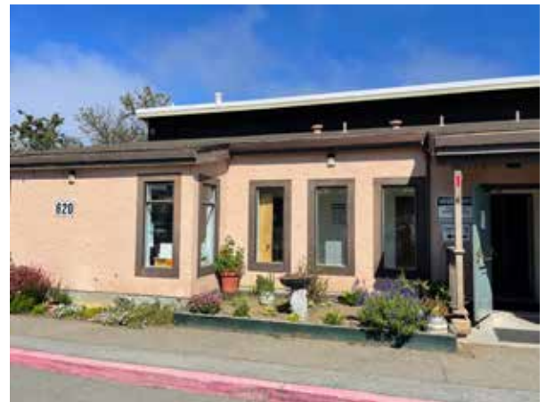
Replace door and door hardware
